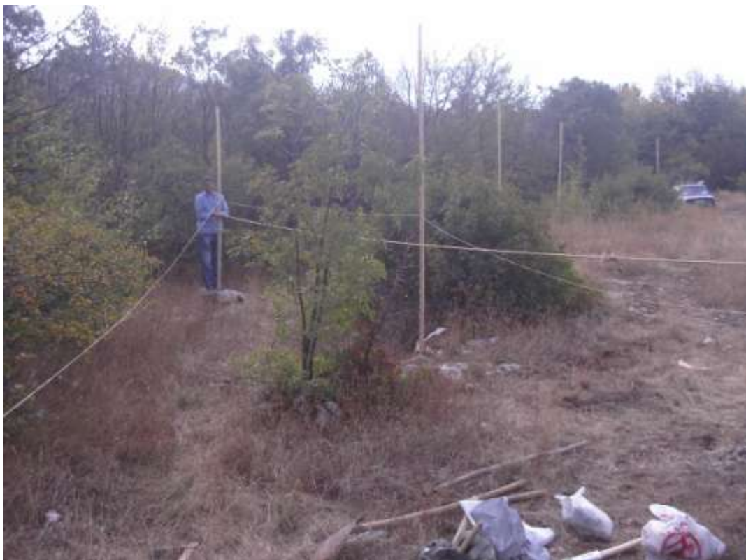
Слика бр. 020 Повезивање штапова канапом и конопцима
